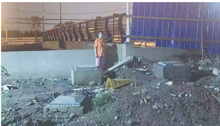
▲ 居民告诉记者,新桥比旧桥抬高了1米 ▲ 上下桥坡度吓人
