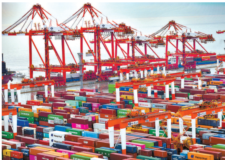
上海洋山四期自动化码头是目前全球最大的单体全自动化码头 本报记者 陈梦泽 摄
