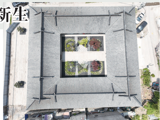
俯瞰平移后的庞家南荫堂 浦锦街道提供
