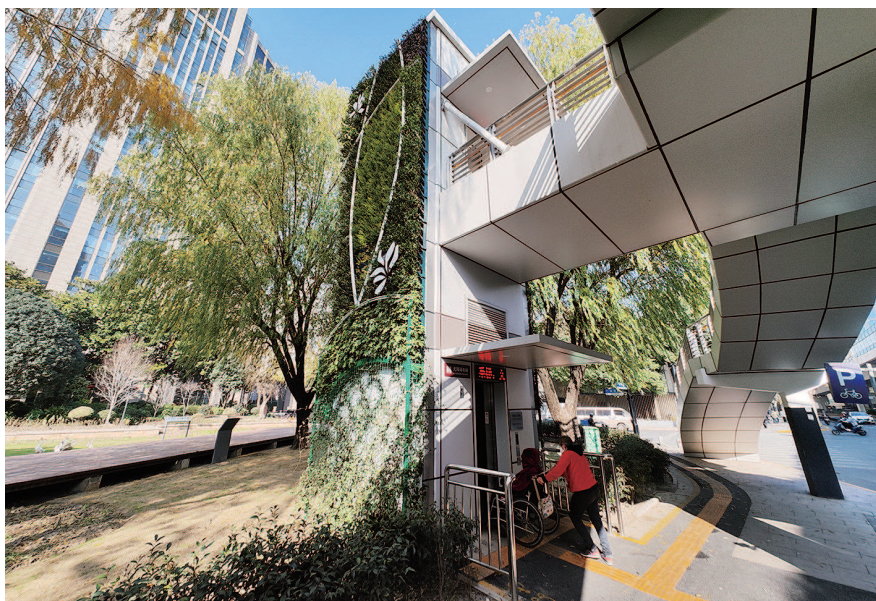
■ 图为重庆南路、南昌路口的人行天桥加装无障碍电梯,方便乘坐轮椅的市民 本报记者 刘歆 摄
