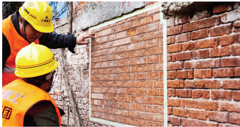
在修缮现场,施工人员使用砖粉修缮技术,尽可能保留百年建筑风貌。 本报记者 陈梦泽 摄
