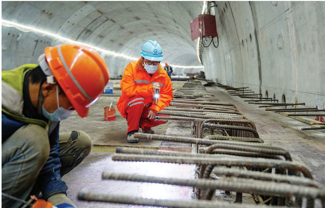
■ 北横通道Ⅷ标项目工地春节不停工,240多名工人两班倒施工
