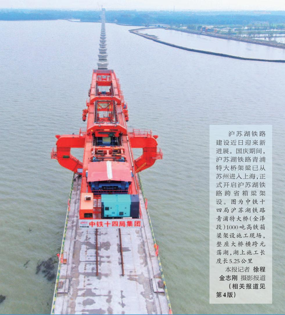
沪苏湖铁路建设近日迎来新进展。国庆期间,沪苏湖铁路青浦特大桥梁梁已从苏州进入上海,正式开启沪苏湖铁路跨省箱梁架设。图为中铁十四局沪苏湖铁路青浦特大桥梁(金泽段)1000吨高铁箱梁架设施工现场,整座大桥横跨元荡湖,湖上施工长度长5.25公里
