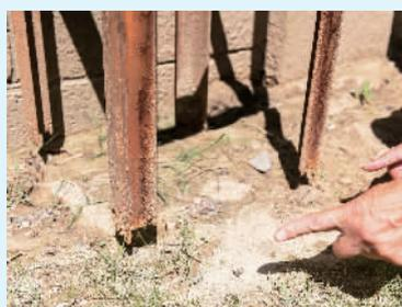
▲ 铁架底部竖柱已烂断
