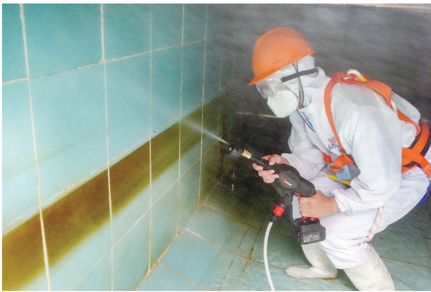
■ 工作人员冒着高温,在水箱内部清洗作业
