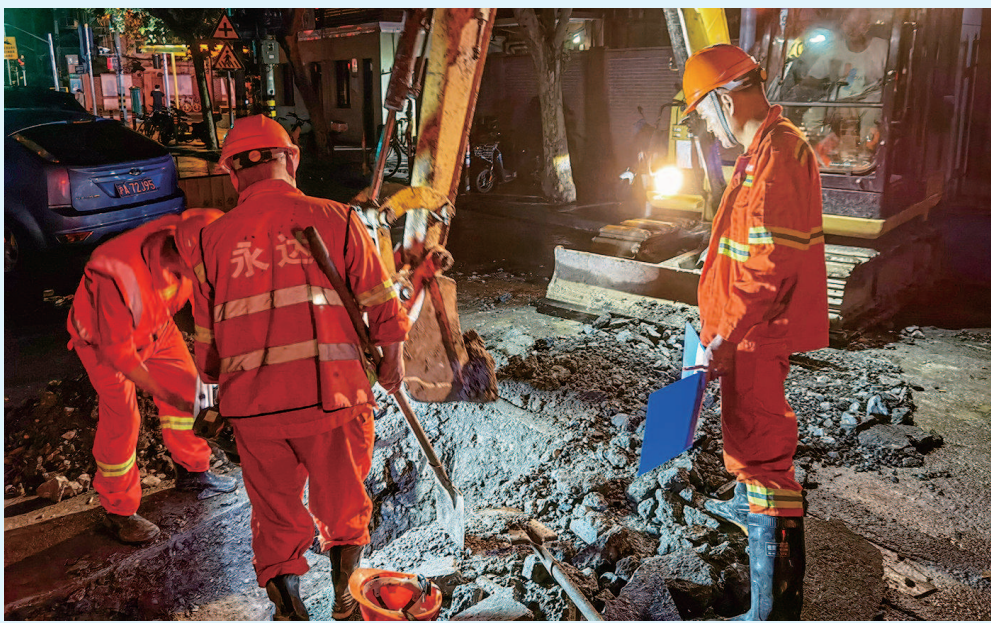
永达市政公司夜间在长宁区进行架空线入地施工
