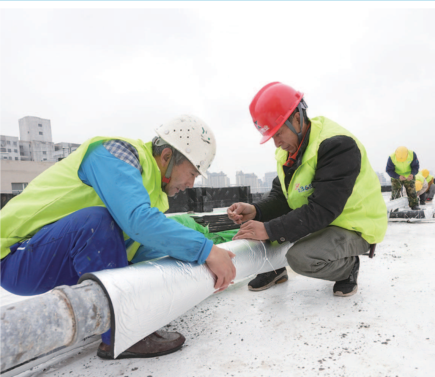
■ 昨天下午，西部集团工作人员对楼顶水管进行包裹
