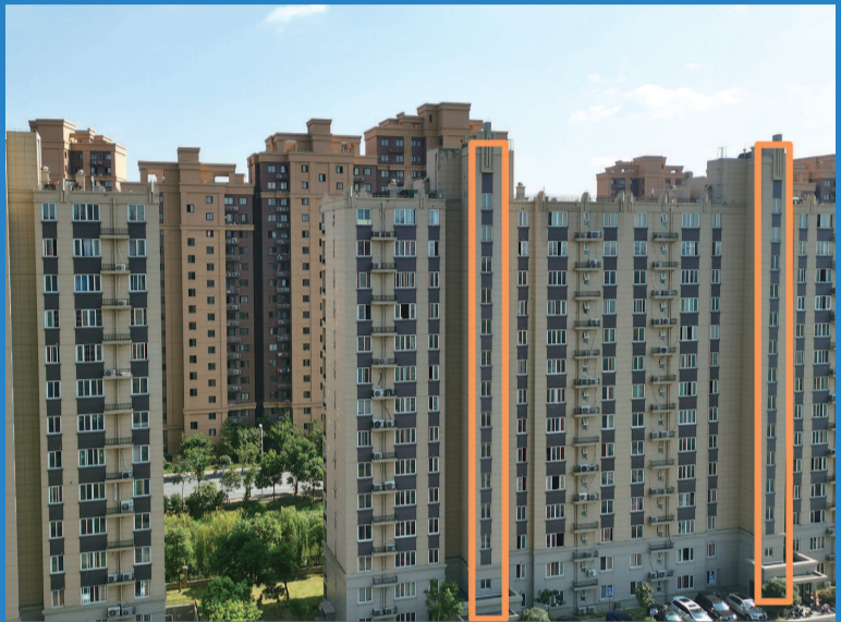
■ “闷罐”小区外立面,标线框内即楼道封闭窗
