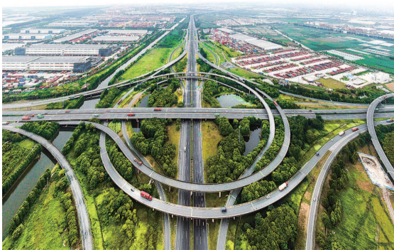
■ 两港大道(新四平公路-S2)快速化工程通车 记者 徐程 摄
