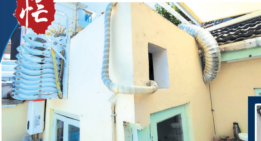
■ 楼上原来的灶间改造成了卫生间
