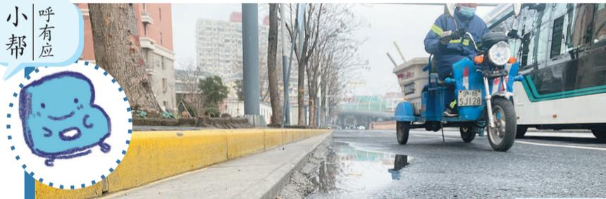
这段军工路侧平石明显高于非机动车道,目测最高落差五六厘米 陈浩 摄
