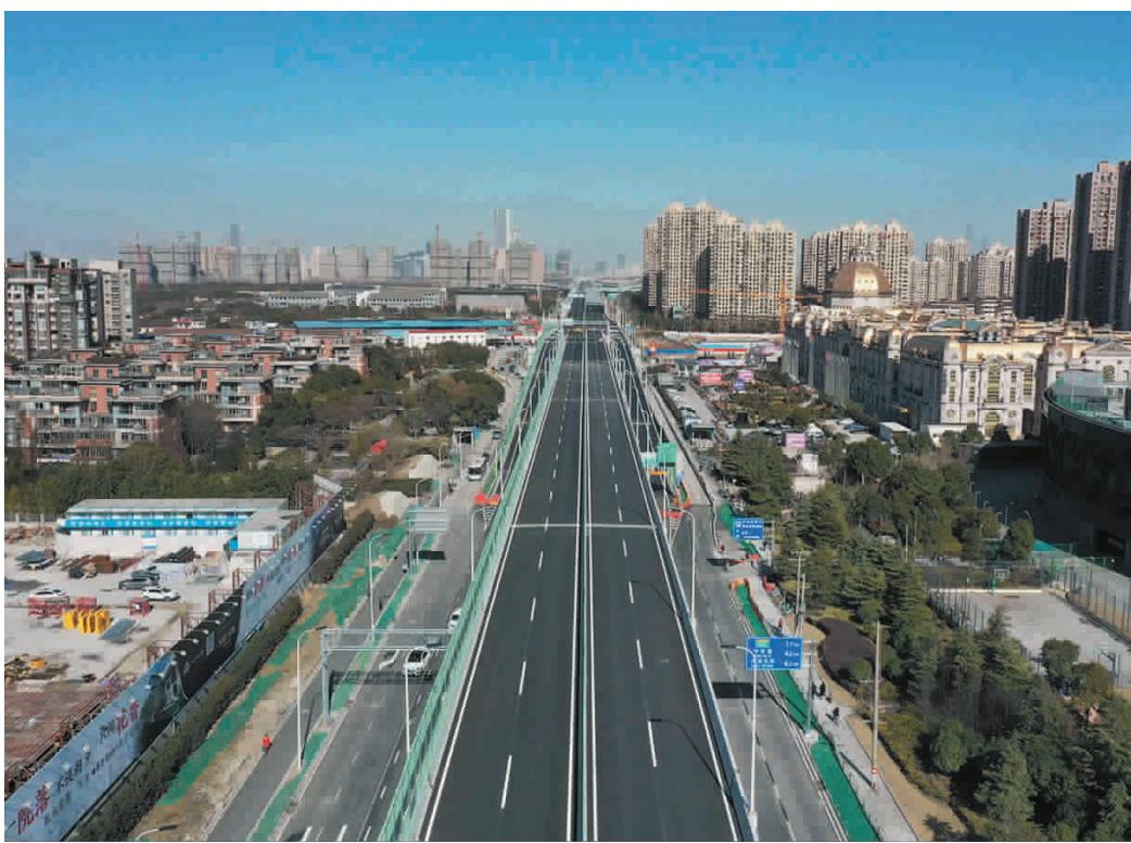
浦星公路芦恒路节点改造工程主线高架
