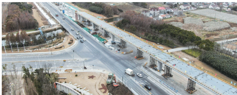
■ 在建中的两港大道快速路工程
