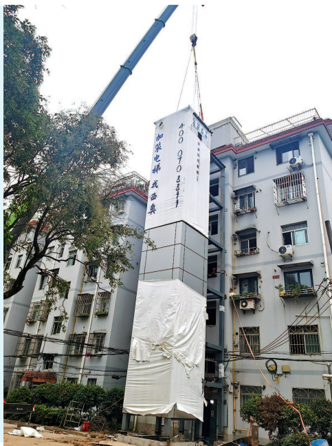
浦东川沙新镇几个小区加装整体式装配吊装电梯，吊装工程就像搭积木，快速又方便。宋亚玲 摄
