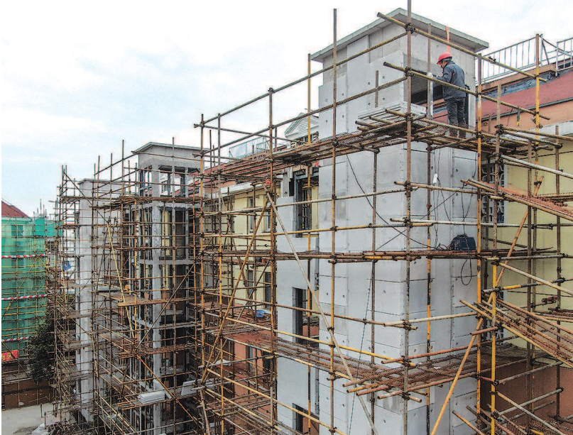
■ 逸仙小区加装电梯工程现场
