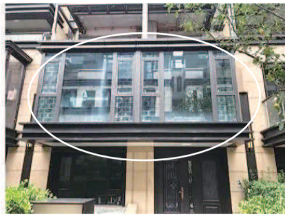
■ 违法搭建后的天台
