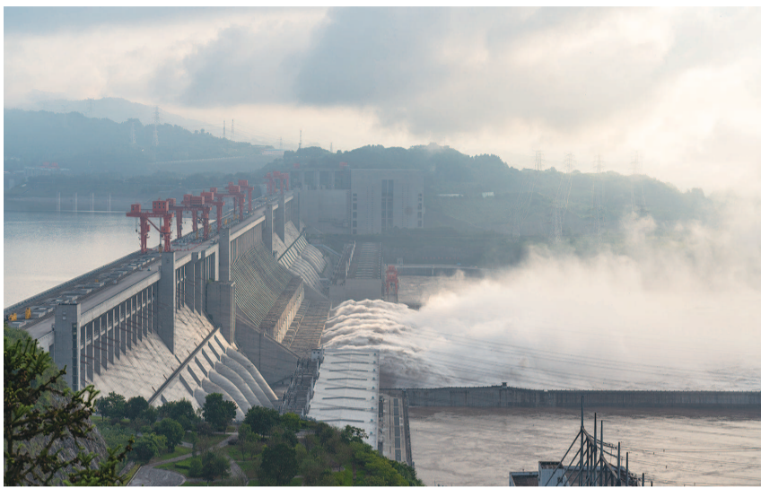
■ 昨天,长江三峡枢纽工程开启泄洪深孔泄洪
