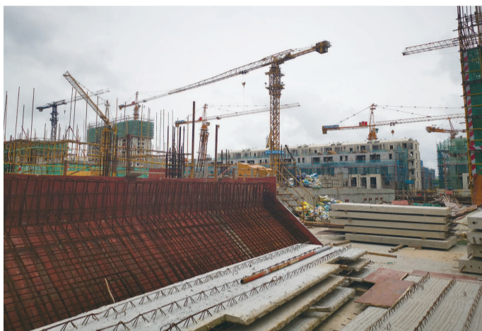
■ 工地停工多时
