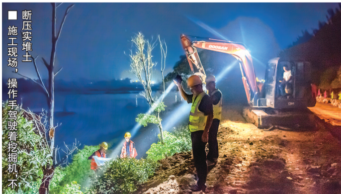
一点五公里防洪堤坝 工人们打着手电筒作业,国道边建起
