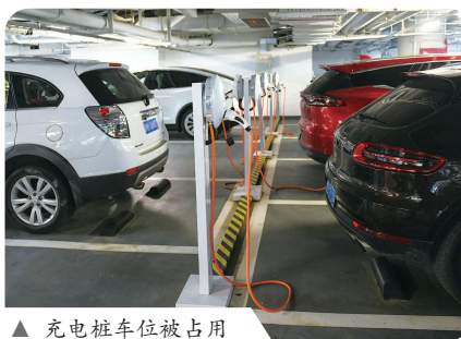
▲ 充电桩车位被占用
