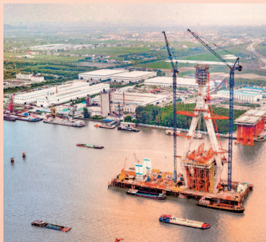
■ 建设中的闵浦三桥
