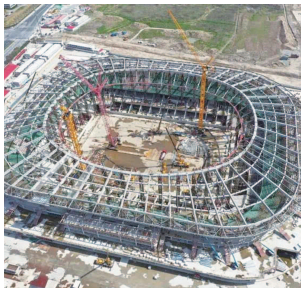
浦东足球场建设工程
